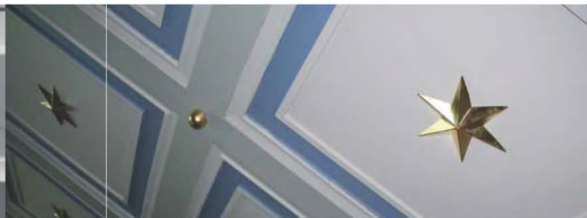
Erneuerung des Sternenhimmels
